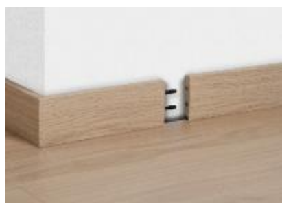
Raccord de deux plinthes le long du mur
